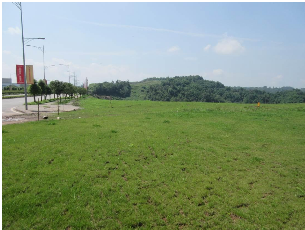
场平区撒播草籽绿化现貌
