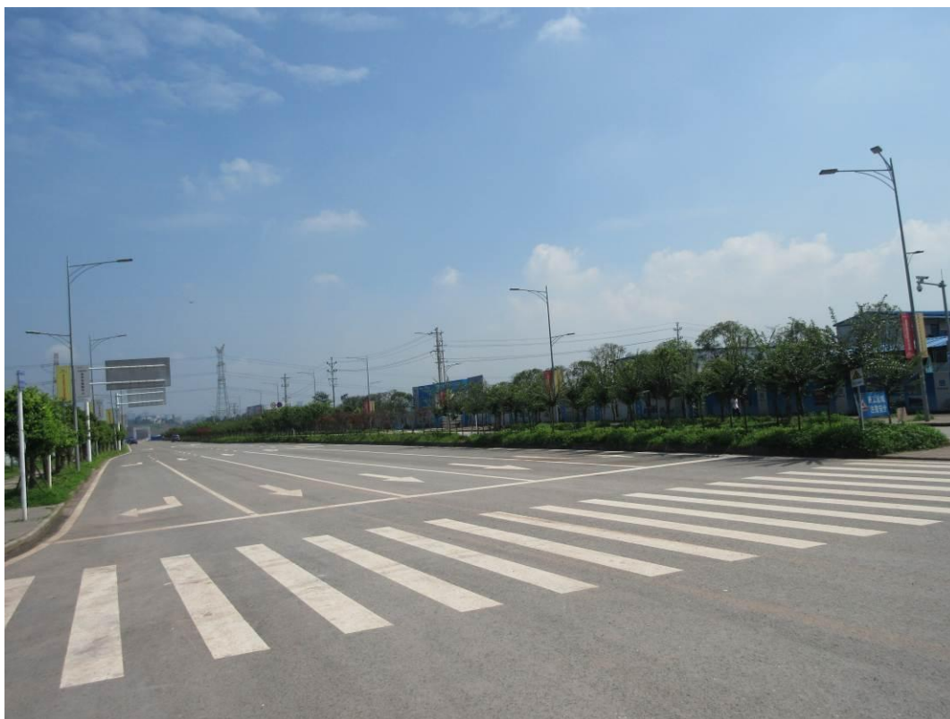
道路管网区综合绿化
