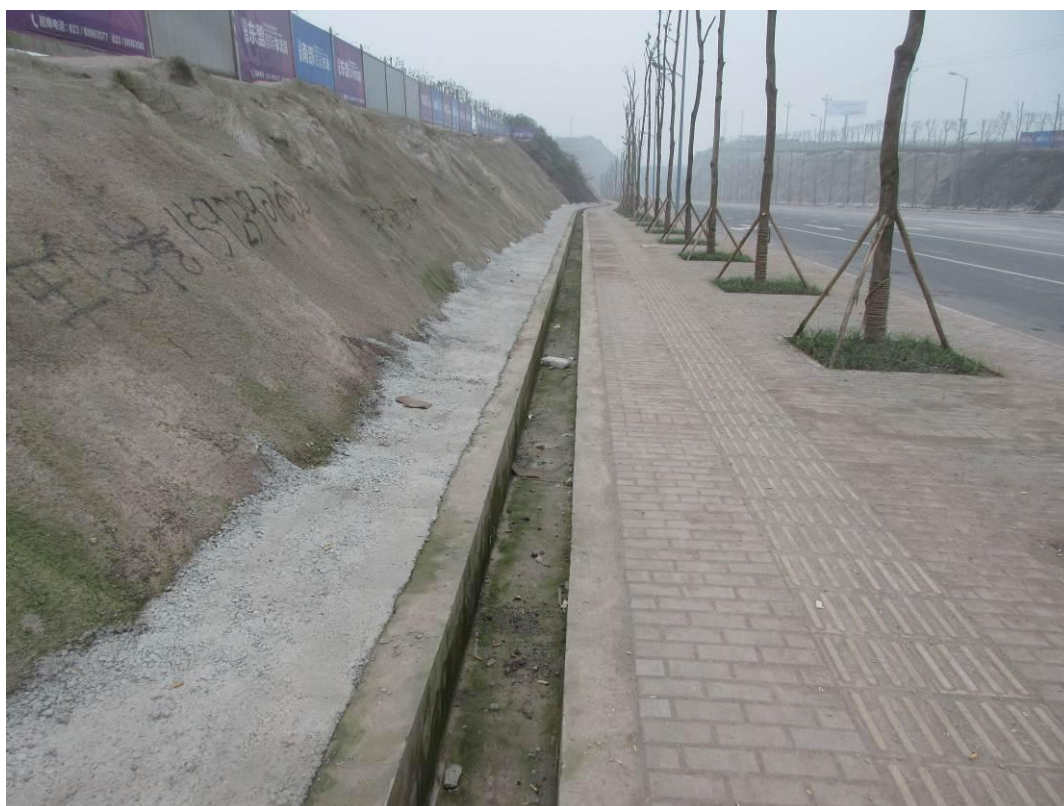
道路区排水沟
