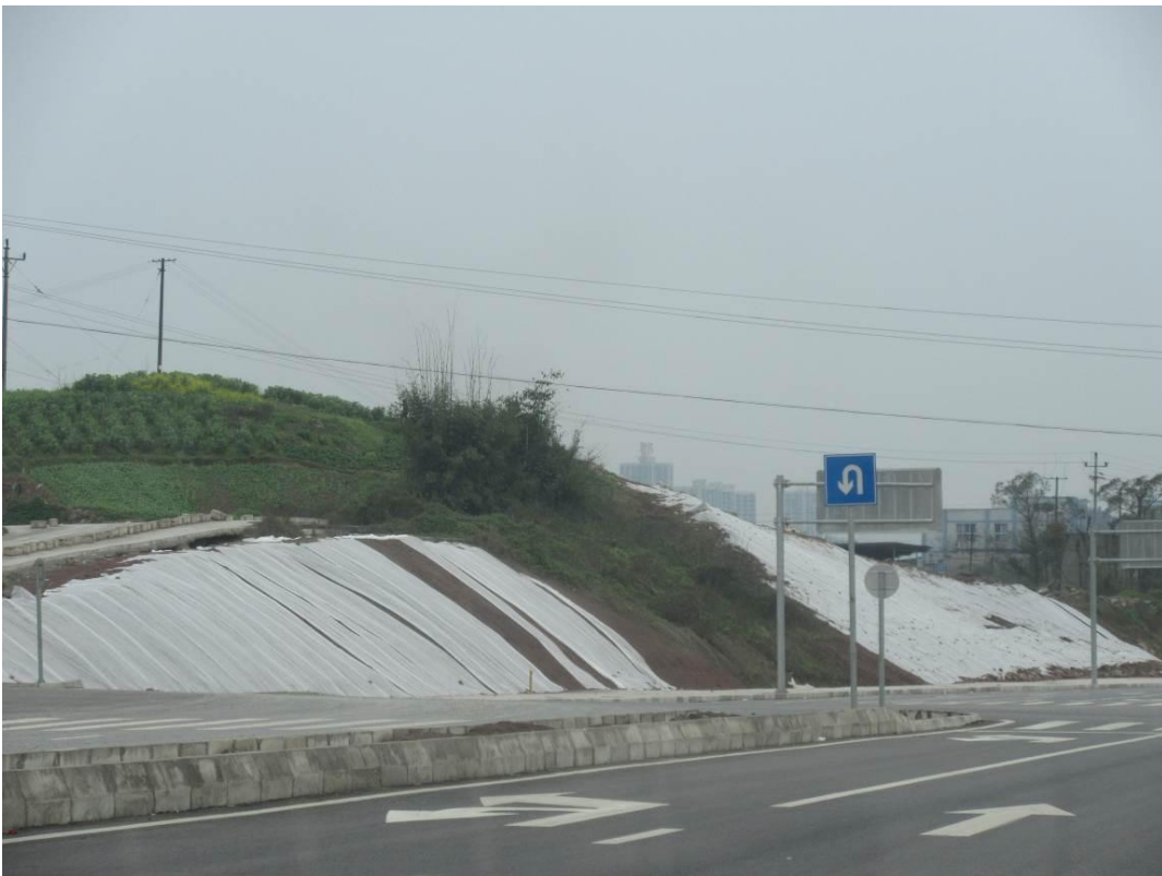
边坡临时覆盖
